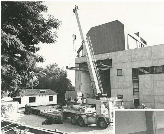
Het plaatsen van een turbine in Eerbeek, Nederland. Plazieren einer Turbine in Eerbeek, Holland. Positioning a turbine in Eerbeek, Holland.
